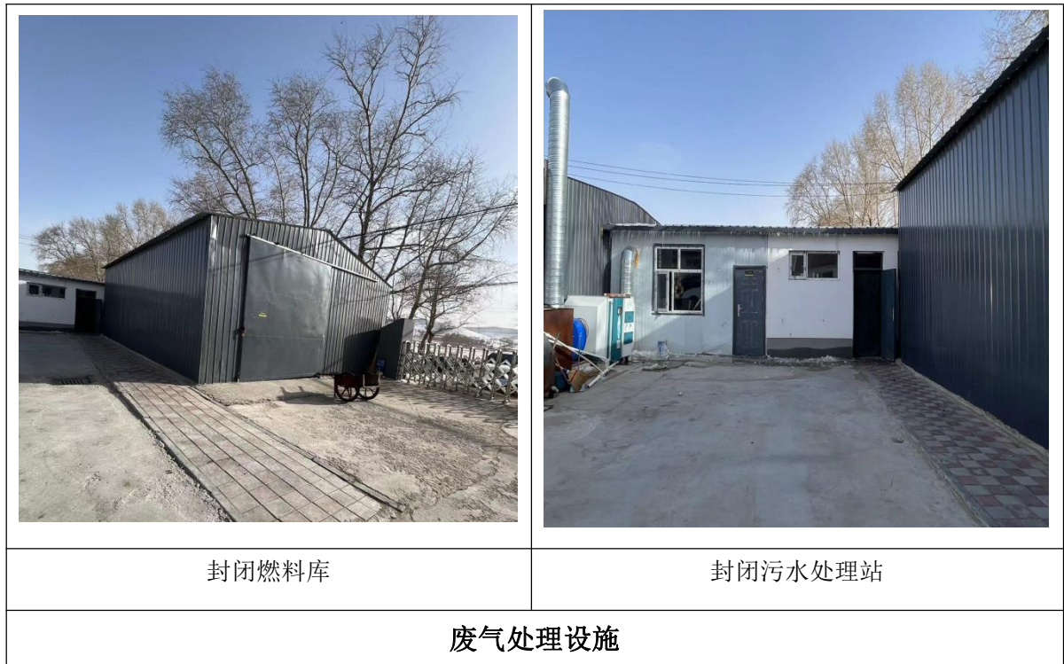
图 3-1 项目废气污染物处理措施现场照片
